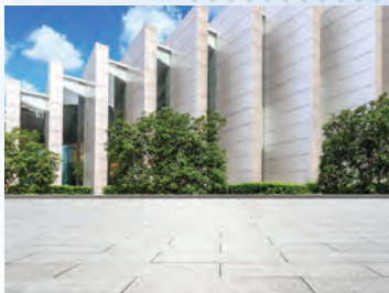
Pisos de Concreto
